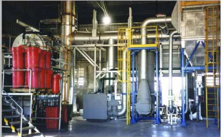
Incinerador pirolítico con post combustor vertical
